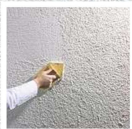
La surface de HAGA Bio-Grundputz (enduit de fond biologique HAGA) doit être rugueuse et à bonne prise pour l'application ultérieure de HAGASIT® (enduit de finition biologique) jet de truelle (p.ex. lisser avec une latte métallique dentée).
