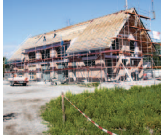
Une isolation sur chevrons en continu facile à mettre en œuvre à Legau, Allemagne.
