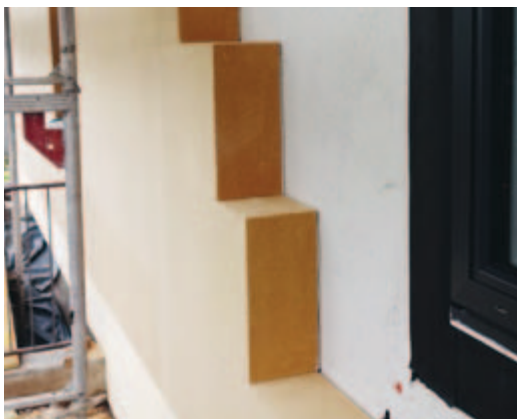
Le PAVAWALL-BLOC est applicable directement sur les supports en pierre ou en bois.
