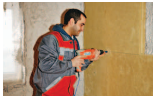
Le PAVADENTRO isole par l'intérieur de manière esthétique notamment dans le cas de façades historiques.
