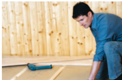
PAVATHERM-PROFIL : panneau isolant résistant à la compression pour la construction des planchers avec lames de bois massif
