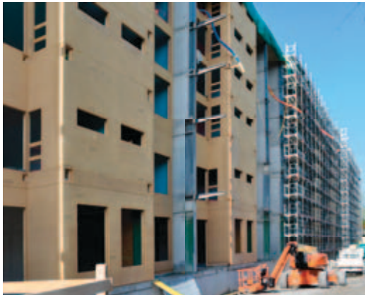
Construction hybride avec DIFFUTHERM 60 mm à Fribourg, Suisse
