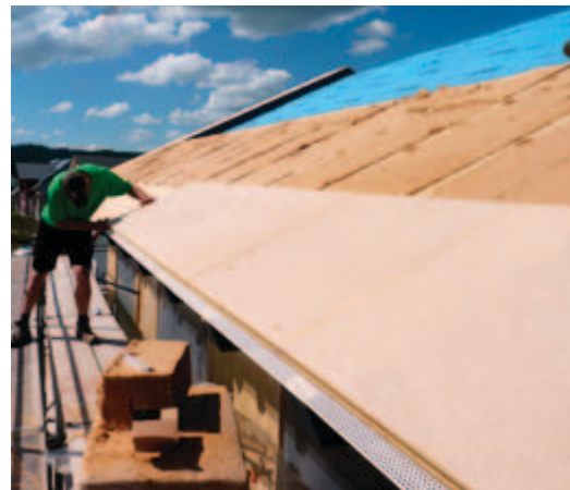
Les systèmes PAVATEX garantissent la sécurité du travail quotidien sur le toit, par exemple à Aichstetten, Allemagne.
