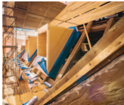
Le système d'isolation PAVATEX convient particulièrement bien à la rénovation de bâtiments historiques comme ici dans le cas de la Chartreuse de Fribourg, Allemagne.
