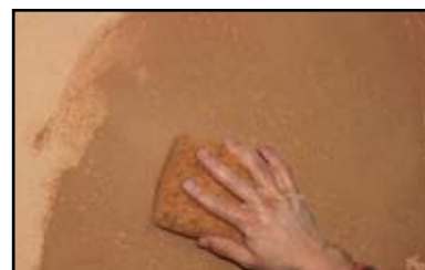
Étape 4 - une fois l'enduit sec, passage d'une éponge semi-humide afin de faire tomber les poussières de surface et faire ressortir le lin.
