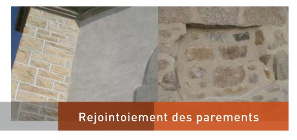
Lorsque les éléments de maçonnerie doivent rester apparents, il est indispensable d'apporter un soin particulier à la finition des joints qui devront aussi assurer une fonction d'étanchéité. Cette finition participera également à l'aspect final de l'ouvrage et devra répondre à des attentes esthétiques. Les mortiers à la chaux sont donc particulièrement adaptés à l'ensemble de ces exigences. La finition des joints pourra s'effectuer suivant deux méthodes :
