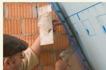
Lorsque le mur est finalement enduit, il suffit d'intégrer CONTEGA PV à la couche intermédiaire de l'enduit. Pour ce faire, rabattre une nouvelle fois le non-tissé et l'armature, appliquer l'enduit sur le mur, derrière CONTEGA PV, puis poser le non-tissé et l'armature dans cette sous-couche d'enduit fraîche et enduire entièrement l'ensemble. C'est fini!
