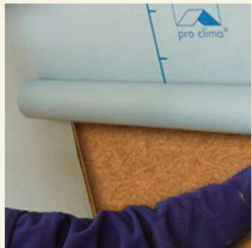
Après fixation de la première bande, poser la deuxième. Le chevauchement des bandes se fait sur les chevrons. Le marquage imprimé sert ici d'orientation. Prévoir environ 10 cm de chevauchement en cas de pose transversale et au moins 1 cm en cas de pose longitudinale.
