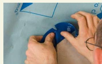
Réaliser l'étanchéité des coins avec de petits bouts de TESCON N°1. Inciser le ruban adhésif au milieu, sur la moitié de sa largeur. Ainsi, il épouse facilement la forme du coin.
