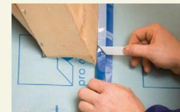
Dans une seconde phase, il suffit alors d'enlever les bandes de séparation restantes pour réaliser le raccord dans son intégralité.
