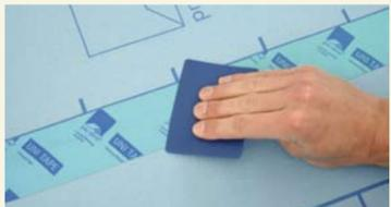
Alternative : pour une réalisation écologique de l'étanchéité de l'enveloppe du bâtiment, il est possible d'utiliser ECO COLL pour effectuer tous les collages entre eux et avec tous les éléments de construction adjacents.
