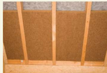
L'isolation thermique se fait entre les chevrons. Nous montrons ici l'utilisation d'un isolant sous forme de nattes. Il faut veiller à ne laisser aucune fente ni fissure entre la natte et le chevron ainsi qu'entre les nattes isolantes.
