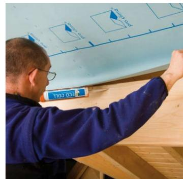
Sur les chevrons ou pannes dont le bois est encore rugueux, appliquer la colle de raccord ECO COLL en un cordon d'un diamètre d'environ 5 mm. Sur les supports rugueux, augmenter éventuellement le diamètre du cordon de colle.
