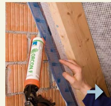
Raccord précis à un enduit avec CONTEGA PV. Avec ORCON F, fixer ponctuellement le non-tissé à la maçonnerie, le plus loin possible dans le coin. Veuillez noter ceci : il ne peut pas y avoir de vide derrière la bande.
