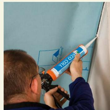
Pour les raccords à des cheminées isolées à double paroi, laisser dépasser DB+ d'environ 3 cm sur la cheminée. Appliquer un cordon de colle ECO COLL d'environ 5 mm de diamètre (éventuellement davantage) et poser la bande avec une boucle de dilatation dans le lit de colle. Ne pas écraser complètement la colle.
