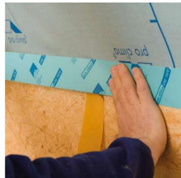
Les raccords aux éléments de construction adjacents sont tout aussi importants que le collage des chevauchements. Pour le raccord avec des éléments de construction lisses non minéraux (comme ici la jambette en panneaux OSB), utiliser UNI TAPE. Procéder de même pour le raccord à un mur pignon.
