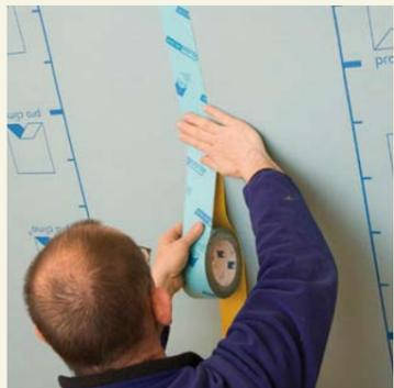
Coller les chevauchements après la mise en place du freine-vapeur. Au niveau des chevauchements, coller les bandes à l'aide du ruban adhésif universel UNI TAPE, sans exercer de traction ni de charge. Le collage doit se faire sur les chevrons. Ne pas appliquer de ruban adhésif par-dessus des plis au niveau du chevauchement, mais ouvrir ceux-ci avant de les recoller. Centrer le ruban et le frotter pour qu'il adhère bien, p.ex. à l'aide de la spatule pro clima PRESSFIX.
