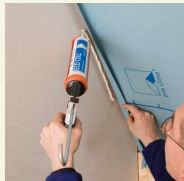
Pour le raccord au mur pignon enduit, appliquer la colle latex naturelle ECO COLL directement avec la cartouche, en un cordon d'un diamètre d'environ 5 mm. Sur les supports rugueux, augmenter éventuellement le diamètre du cordon de colle.
