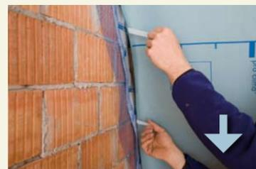
Approcher le freine-vapeur. Retirer le film de séparation de CONTEGA PV et fixer le non-tissé avec le ruban adhésif à la couche d'étanchéité à l'air. Frotter le ruban pour qu'il adhère bien.
