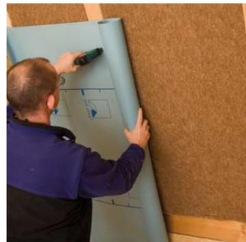
La bande freine-vapeur et d'étanchéité à l'air DB+ se pose sous l'isolation thermique, du côté intérieur. Elle protège l'isolation thermique contre l'humidité et les moisissures. La bande n'a pas de face avant et arrière et peut donc être posée avec le côté imprimé ou non tourné vers l'espace intérieur. Les agrafes devraient avoir une largeur de 10 mm et une longueur de 8 mm et être placées à une distance maximale de 10 à 15 cm.
