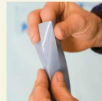
L'étanchéité à l'air est également importante aux endroits qui comportent des angles. Pas de problème avec le ruban adhésif d'angle TESCON PROFIL ! Celui-ci est équipé de trois bandes de film de séparation. Ainsi, il est possible d'activer d'abord seulement une partie de la surface collante et d'effectuer un côté du collage.
